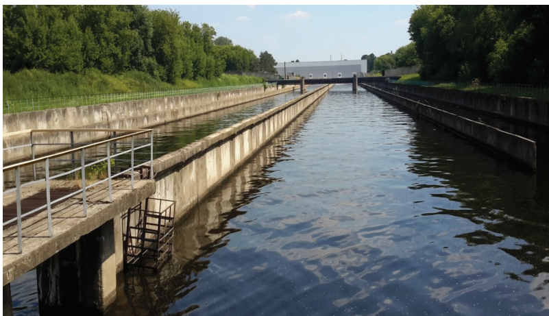
Рисунок 1. Сбросной канал ОАО Мосводоканал Курьяновские очистные сооружения.
