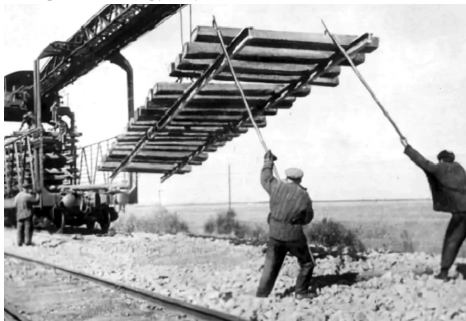
Строительство железной дороги
