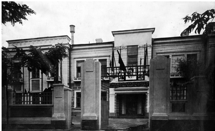
Центральный корпус института
